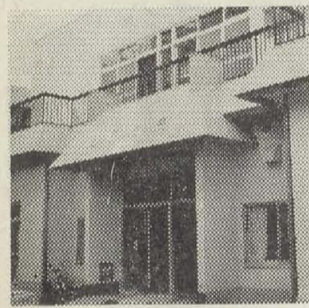
▲ 完成した弓削集会所
