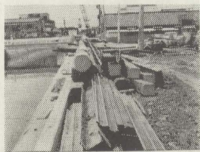
改修工事中の恩智川
