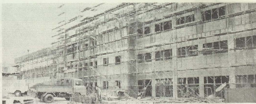
建設が進む高安西小学校
