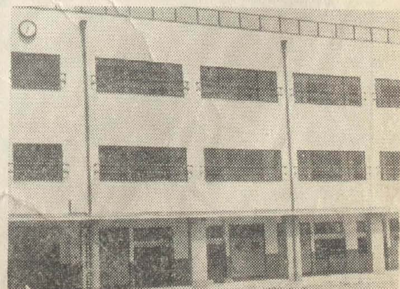
学校, 校舎建設 (小学校)
