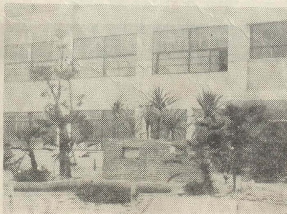
学校, 校舎建設 (中学校)
