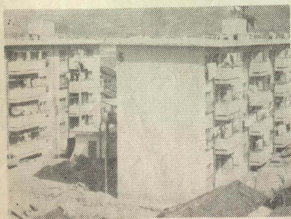
改良住宅建設
