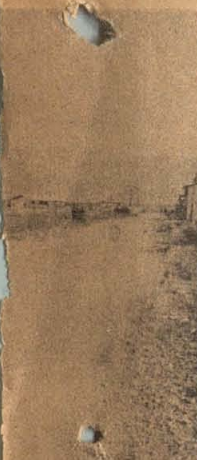
尾停車場線道路
