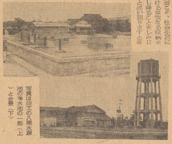
写真は竣工の八尾水源池の浄水池の一部(上)と全景(下)
