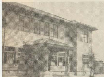
八尾市警察署完成
