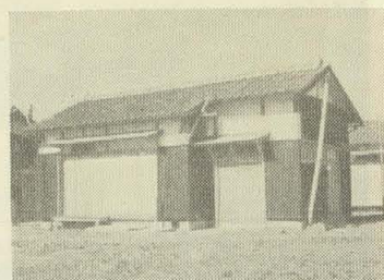
市営住宅30戸建設
