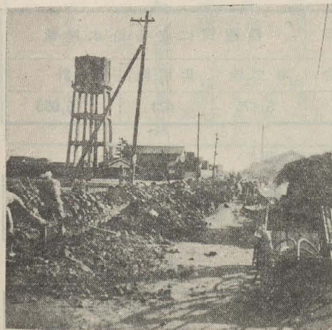
配水管布設工事
